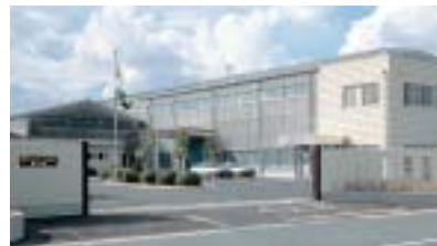
豊川工場 Toyokawa Factory (Machineries)
